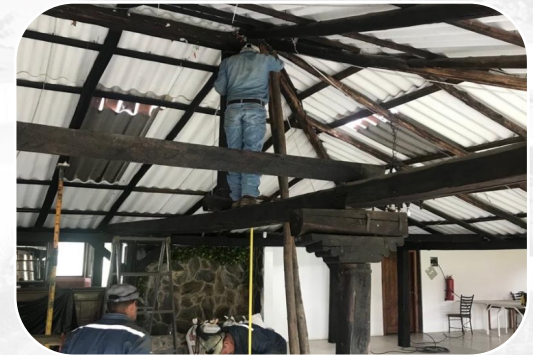
REFORZAMIENTO DE LAS COLUMNAS EN EL SALÓN LOS LIBERTADORES
