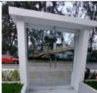
Puerta peatonal de Ingreso
