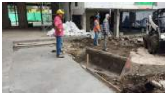
Vista fachada frontal – Trabajo con bob cat Fuente: Fotos del Soporte A43
