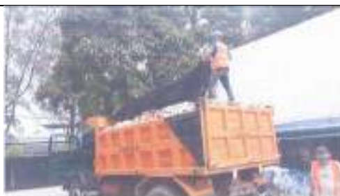
Desalojo de escombros
